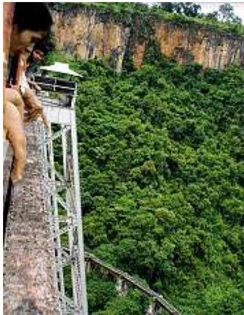
Im Schrittempo über den legendären Gokteik Eisenbahn-Viadukt.
